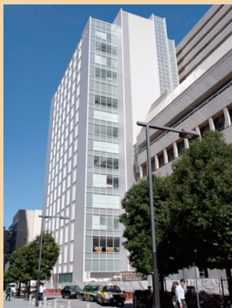
新教育研究棟 外観（南側）
